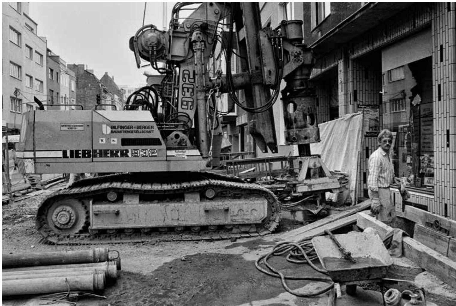
Umbruch – wörtlich genommen: 1983 beginnt auf der Venloer Straße der U-Bahn-Bau, 1990 fahren die ersten Bahnen
