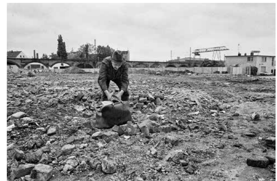
Ehrenfeld als Baustelle: Das Gelände zwischen Bahntrasse und Herbrandstraße (unten), wo heute das Cinenova steht, ist Brachland. Von den hier abgerissenen Werkstätten zeugen nur vereinzelte Backsteine
