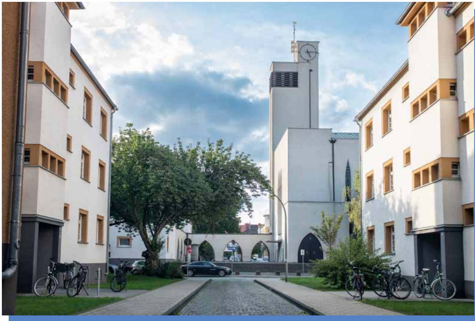
Wärme gedämmte Moderne: Rosenhof-Siedlung Fotos: Jennifer Rumbach
